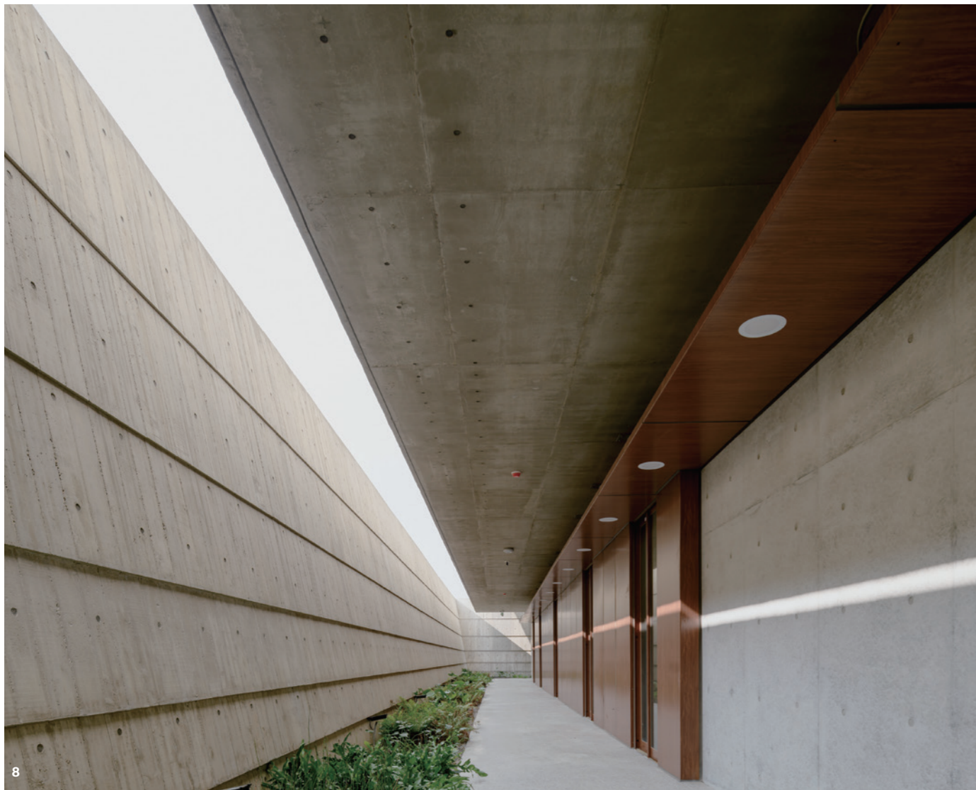
8 木紋清水模斜牆 9、10 建築物中央天井使得熱空氣上升、冷空氣下降達成循環對流之無空調空間 11 納骨櫃櫃體全數採用鋁合金製品搭配smc門板
